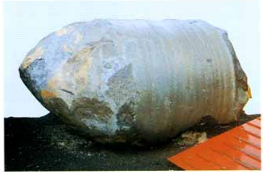
切削された1.5m径の大転石
