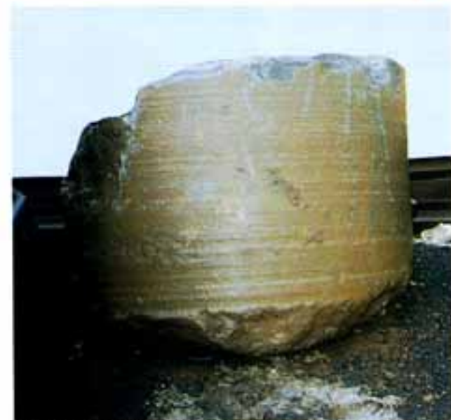
■南箱根ダイヤモンドピラ・ビレッジリゾートマンション 基礎施工現場
